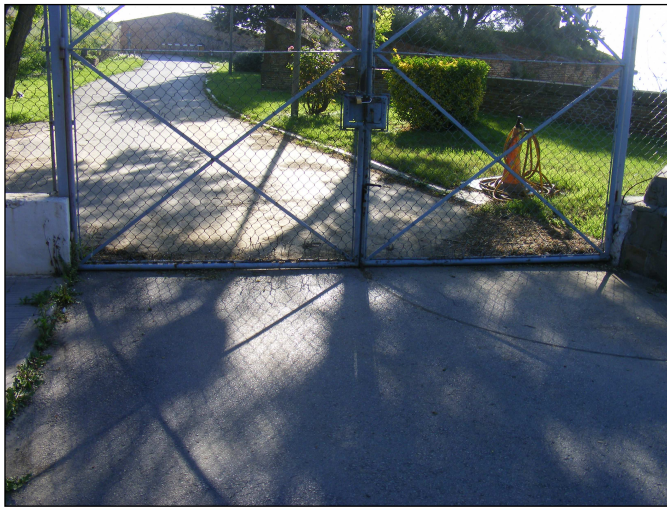
Vista inicial de la rasa.
