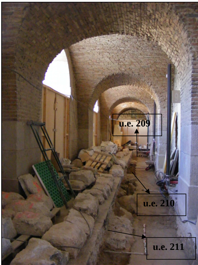
Vista de conjunt de les u.e.'s 209, 210 i 211.
