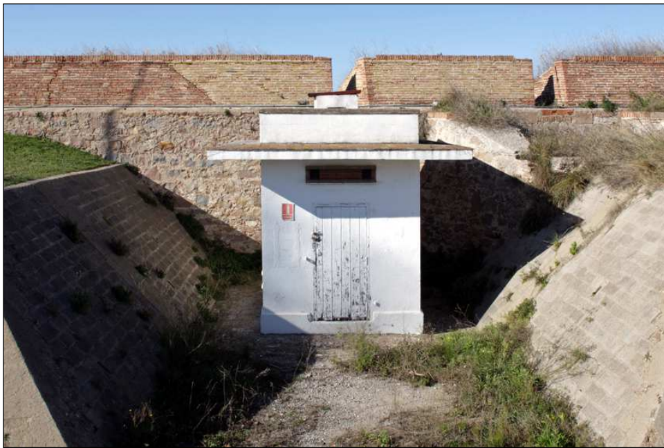
Vista de l'exterior. S'observa el soterrament de l'edifici 8.
