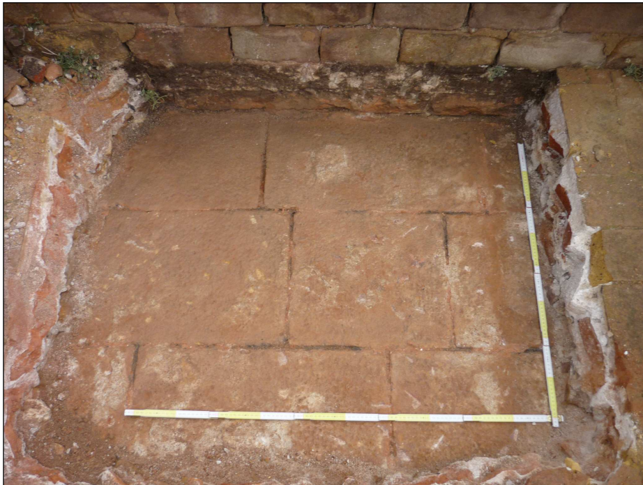
Detall del paviment antic de la coberta de les voltes del pati d'armes que es va descobrir en el transcurs de la intervenció de desembre de 2009. Foto Karin Hanzbecher
