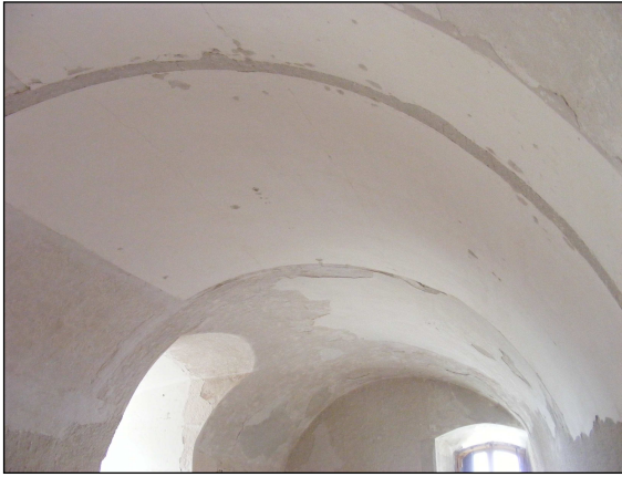
Vista de la volta u.e. 164.
