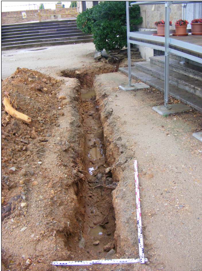
Vista de la rasa a l'hornabec davant l'edifici d'oficines.
