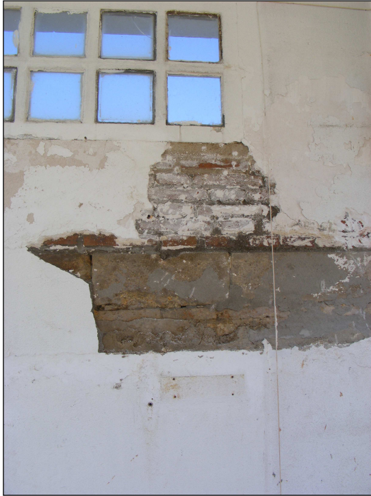
Detall d'un dels sondejos parietals.
