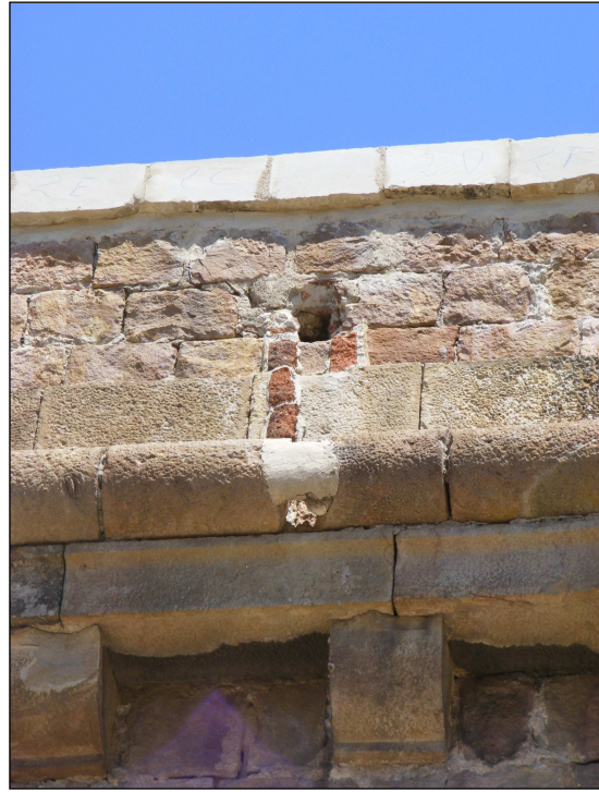
Detall de l'antic desguàs de la coberta.
