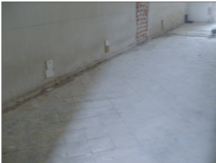
Vista general del paviment u.e. 127.
