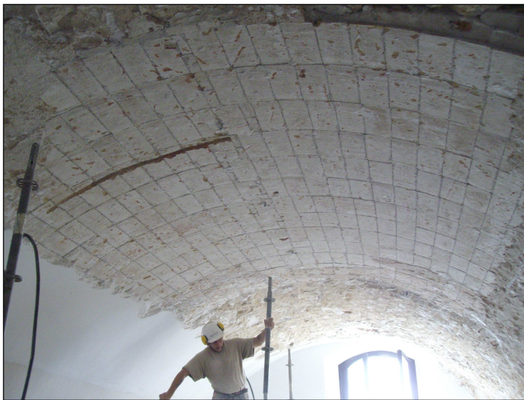
Vista general de la reparació u.e. 62.
