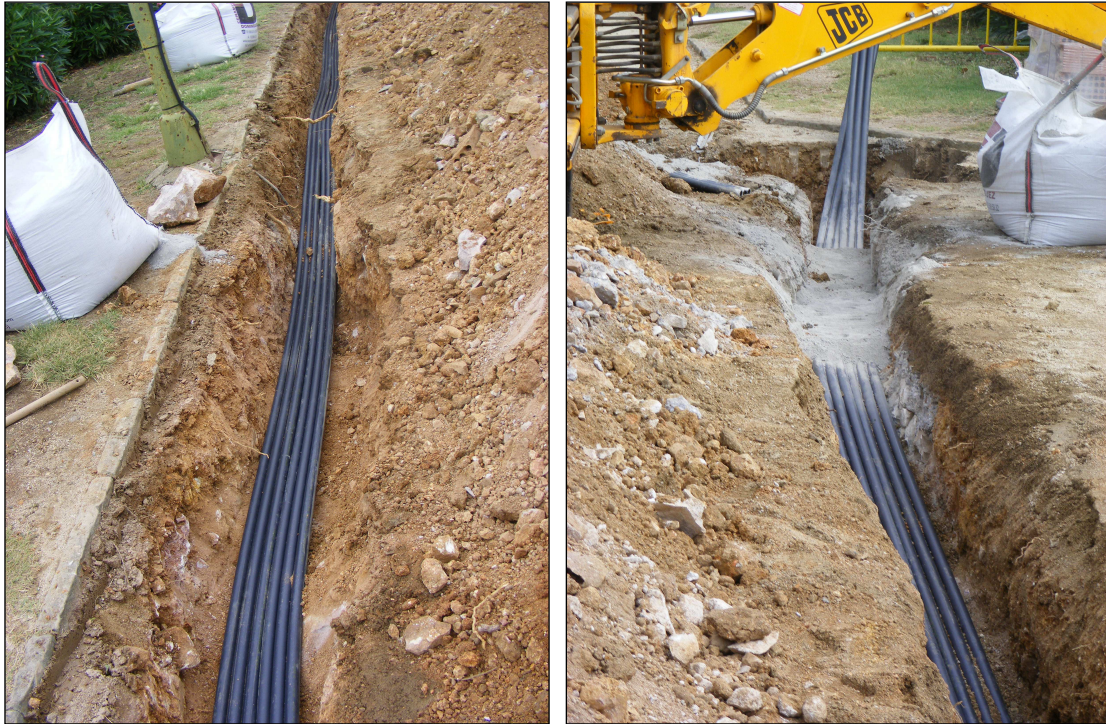
Pas dels nous serveis i el seu procés de cobriment dels mateixos.
