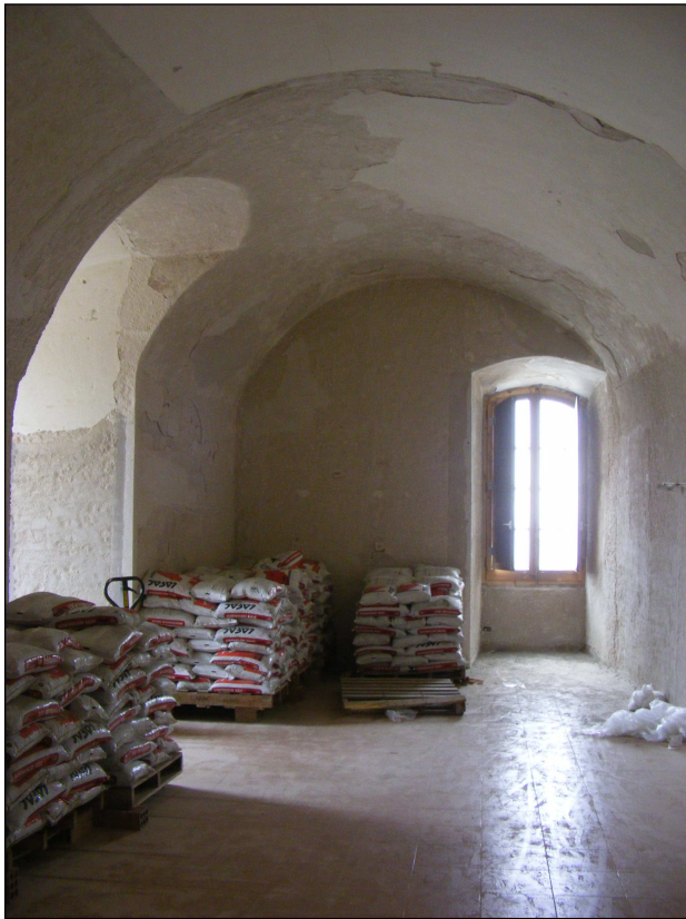
Vista inicial de la sala 5.
