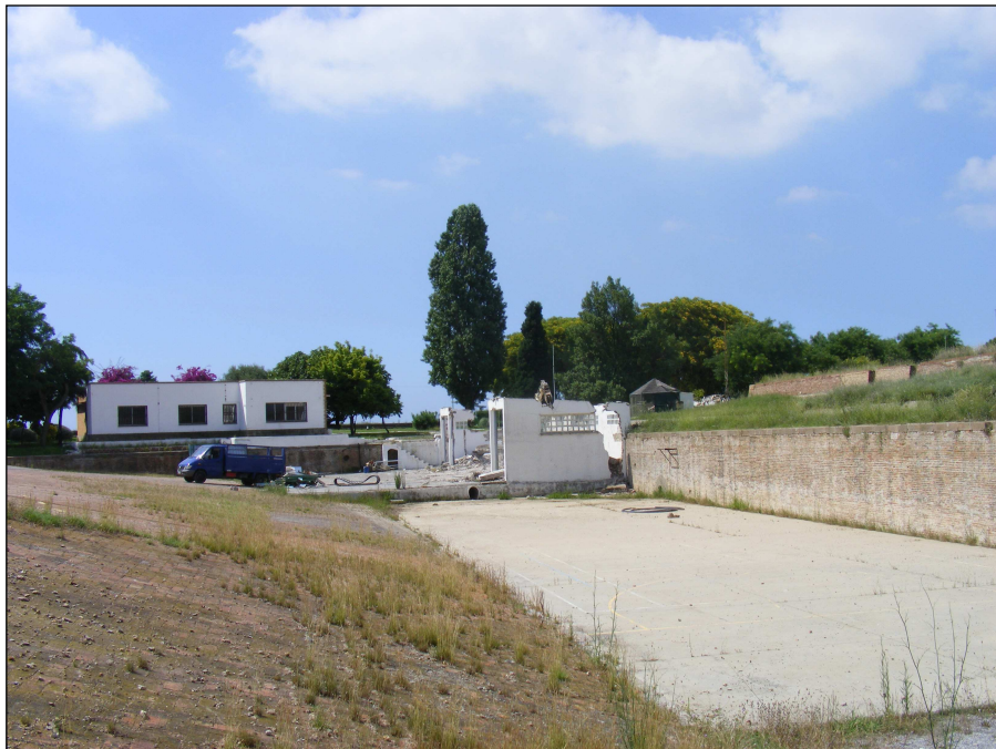
Vista general de l'estructura de la bassa en el procés d'enderroc de l'edifici 7, a l'esquerra l'edifici 2 encara dempeus i el paviment u.e. 378 de la bassa disposat en un pla inclinat.
