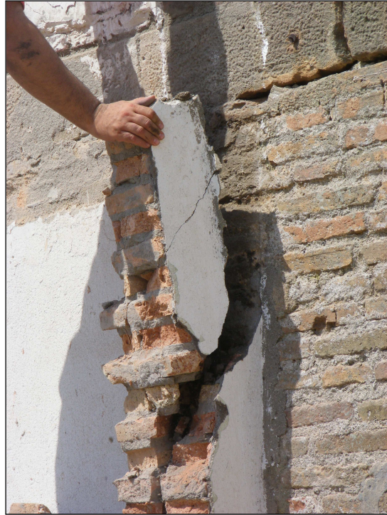
Procés d'extracció de la paret de l'edifici 7.
