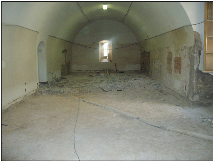
Procés d'afectació del paviment u.e. 102 que deixa a la vista la rasa u.e. 71.
