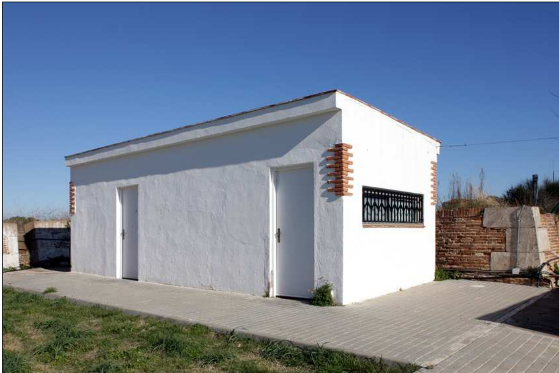
Vista general de l'edifici 6.
