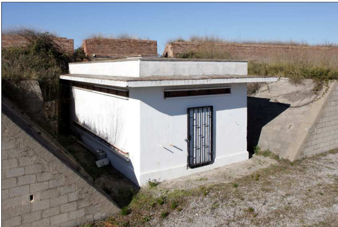
Vista de l'exterior de l'edifici 10.
