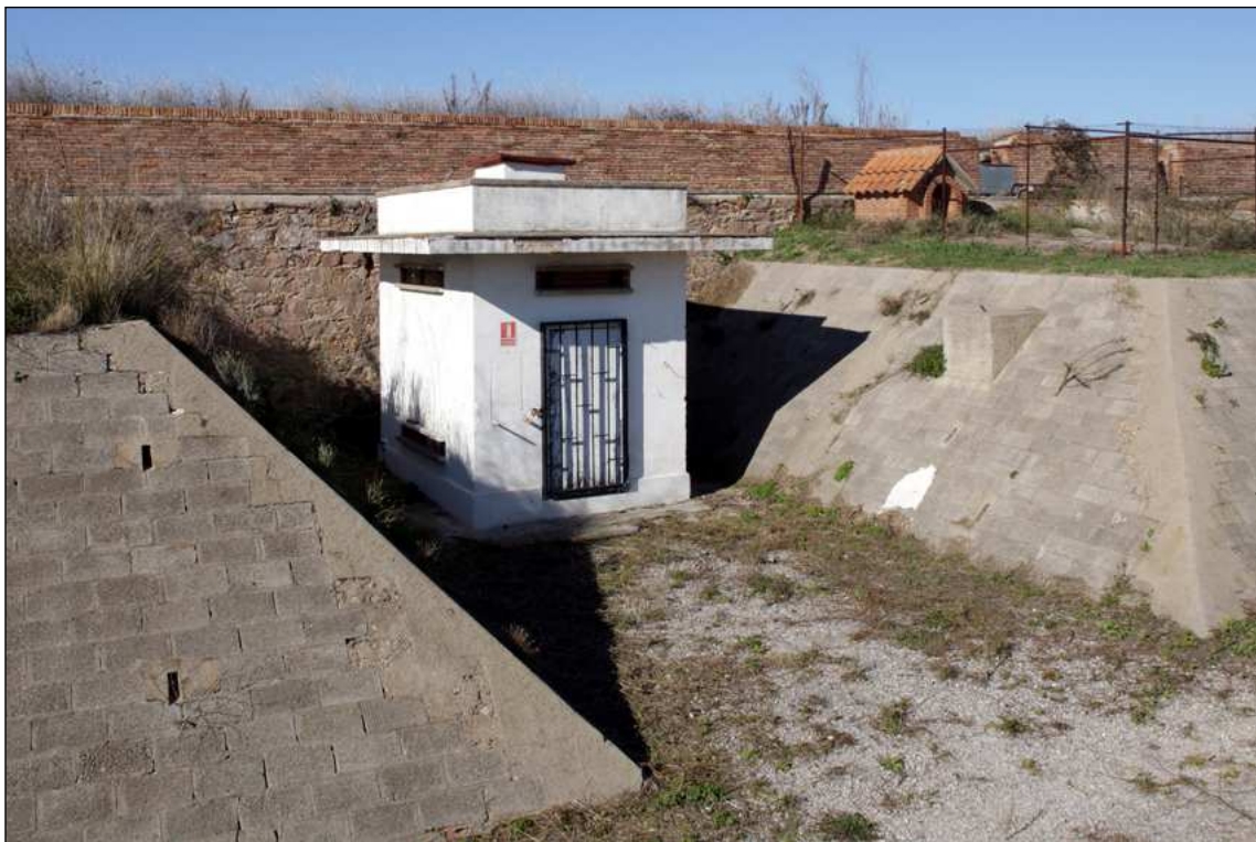
Vista de l'exterior de l'edifici 11.
