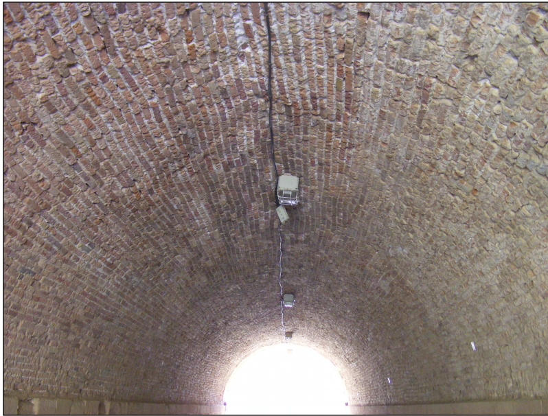
Vista de la coberta del pas que comunica el primer amb el segon recinte.
