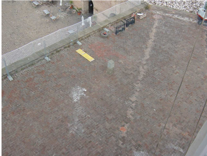
Vista de la coberta del terrat en el moment d'iniciar-se les obres.
