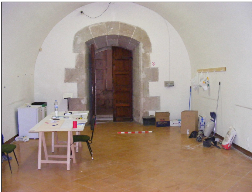
Vista inicial de la sala 20.
