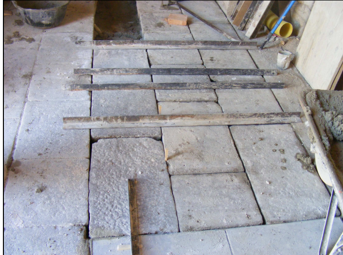
Reinstal·lació del paviment u.e. 201.
