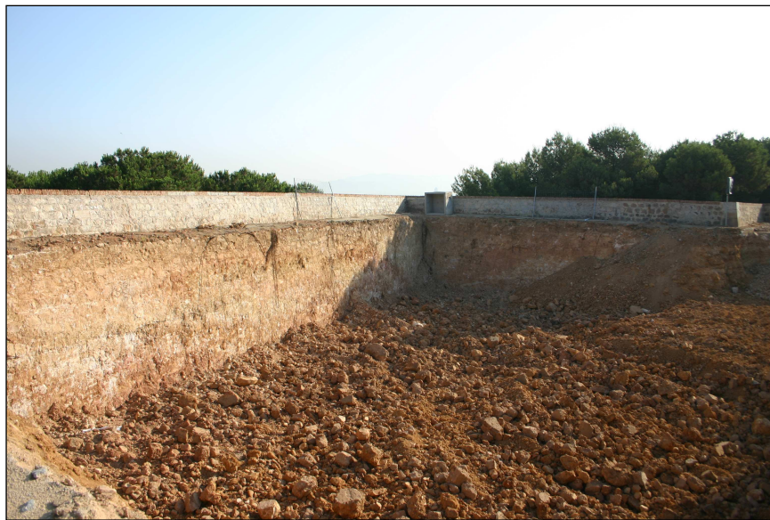
Vista de la plaça d'armes del camí cobert durant el procés de buidatge. S'observen les dimensions del mur. (Foto Daniel Alcubierre)
