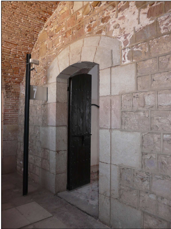
Vista de la porta d'accés a la sala 7.
