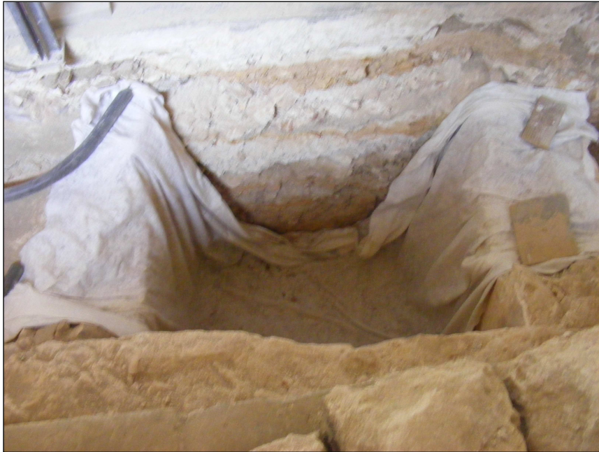
Procés de cobriment del dipòsit annex a la cisterna.
