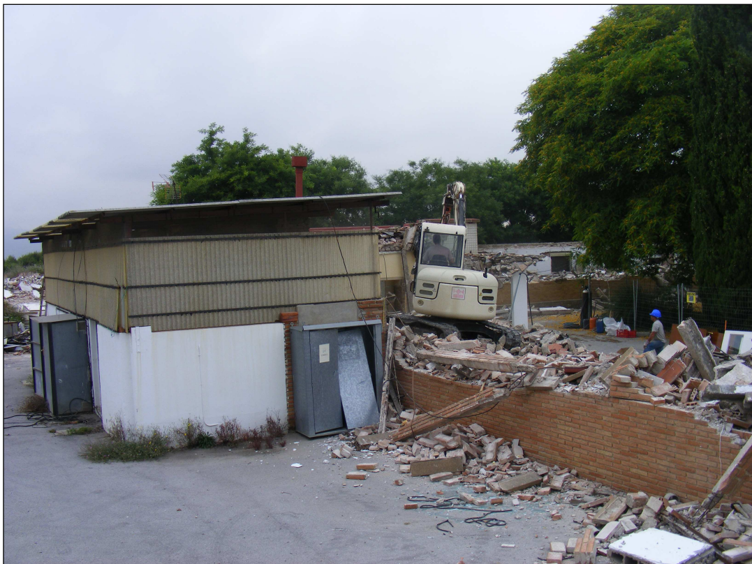
Procés d'enderroc dels edificis 4 i 5.
