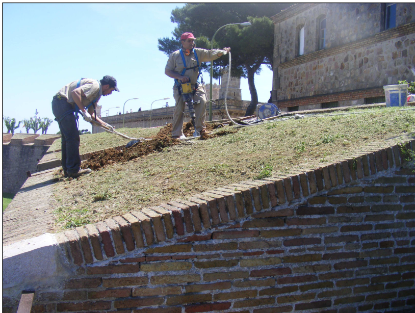
Procés d'obertura de la rasa a l'espai entre troneres.
