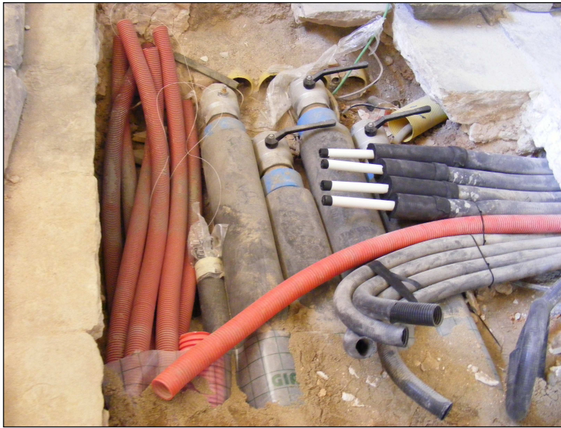
Detall dels serveis que es condueixen per la rasa de serveis. En concret davant de la sala 13.
