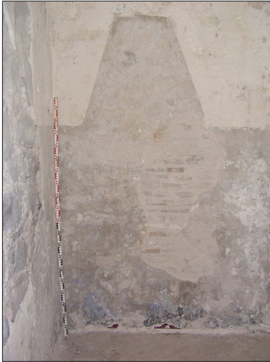
Vista inicial de la llar de foc u.e. 225
