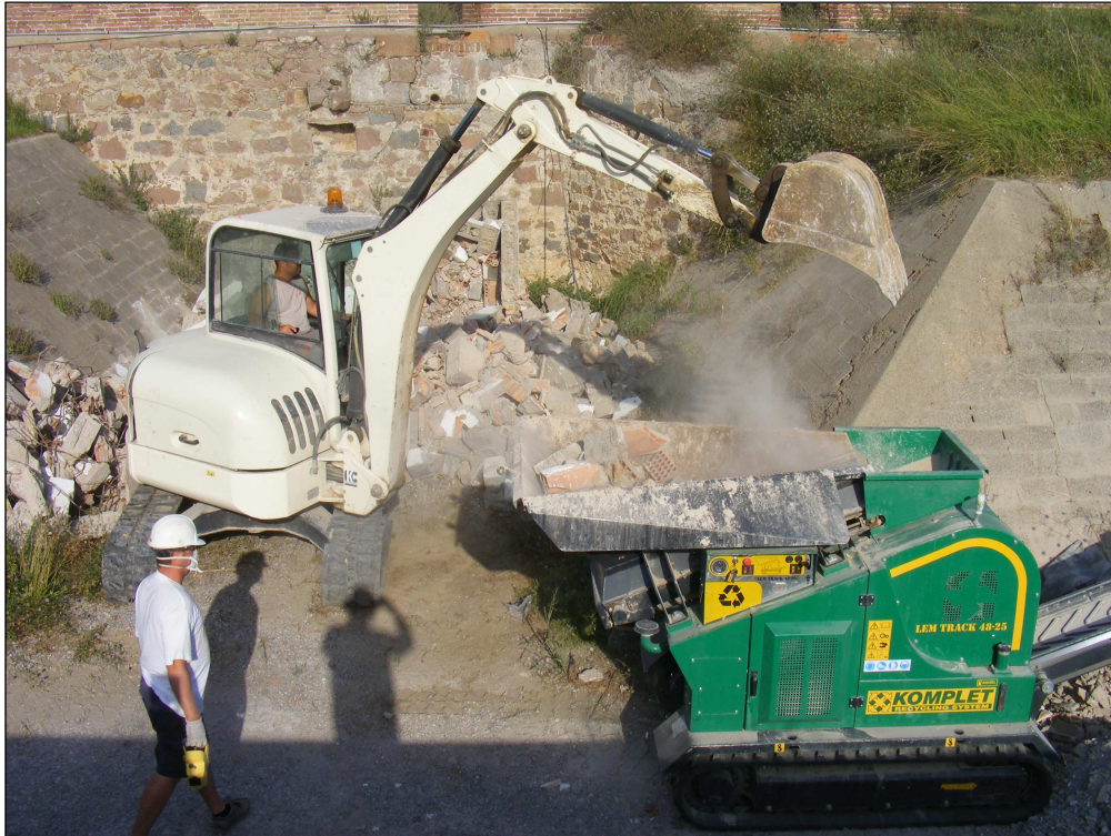
Detall del procés de càrrega de runa a la trituradora.
