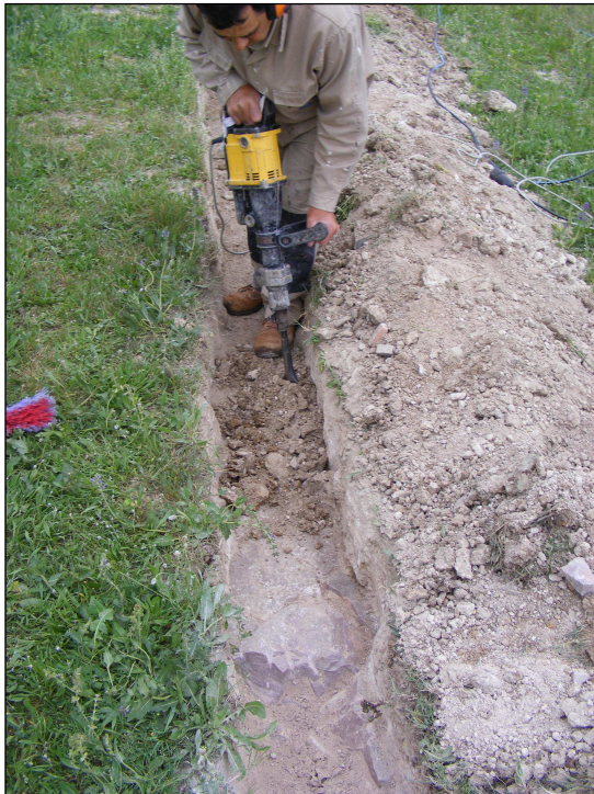
Procés d'excavació de la u.e. 341 per delimitar el paviment u.e. 352.
