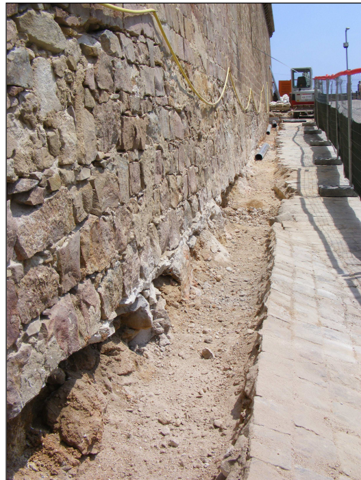
Vista general final de la rasa de serveis.
