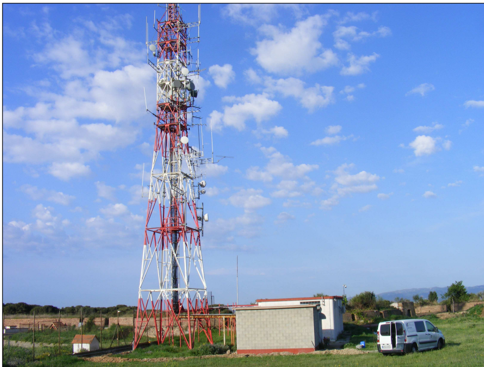
Vista general de l'antena i dependències annexes al voltant de les que es realitza la rasa.
