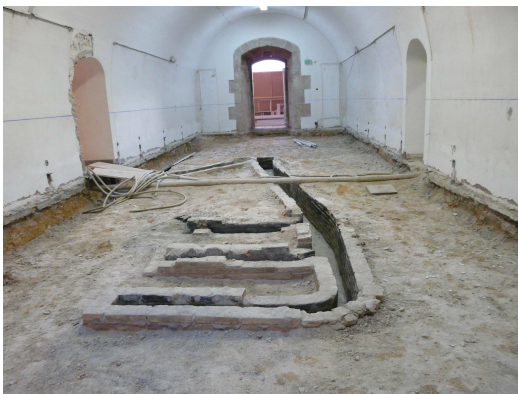
A la imatge de l'esquerra les canalitzacions de ventilació aparegudes al subsòl de la sala 16. A la dreta una fotografia del fons de l'empresa Closa corresponent a la mateixa sala abans de les obres d'instal·lació del museu militar a Montjuïc, on encara es conservava l'antiga cuina.
