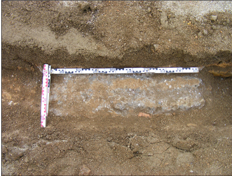
Detall del paviment de formigó u.e. 326.
