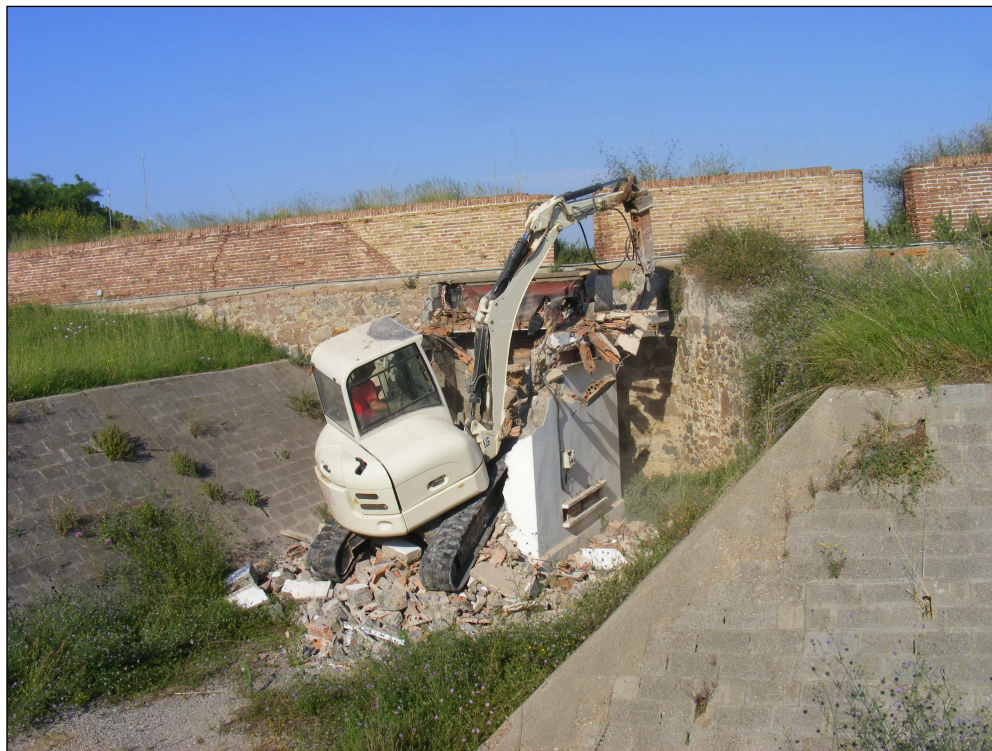
Vista del procés d'enderroc del Polvorí identificat com a edifici 8.
