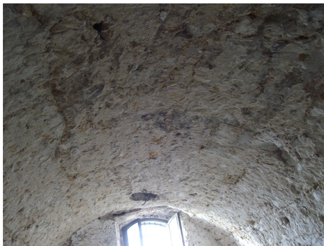
Detall de la volta de la sala 9, s'observa que està construïda amb encofrat de maçoneria de calç i pedra.
