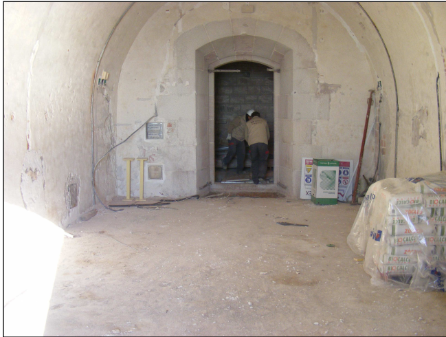
Vista de la porta que comunica amb el passadís un cop extrets els paviments.
