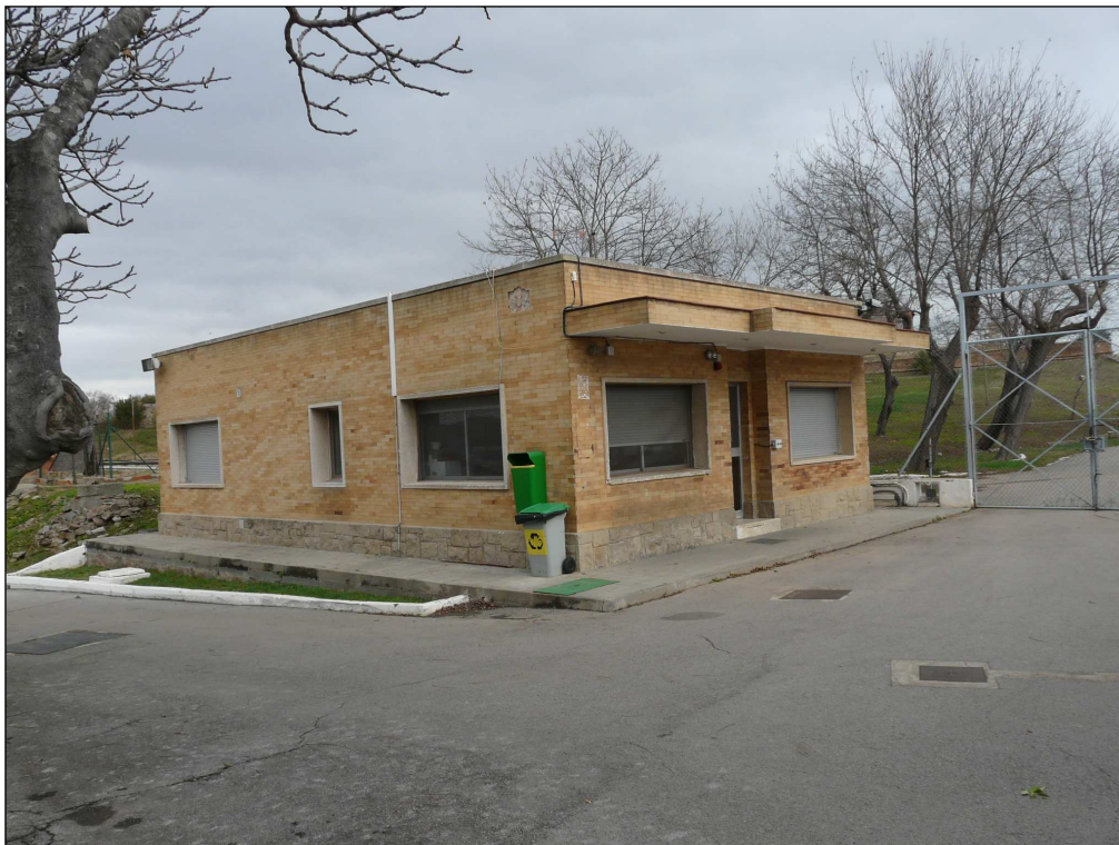
Vista general de la façana principal i d'una de les laterals de l'edifici 1.
