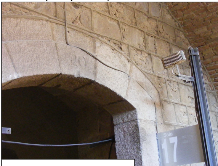
Vista de la porta d'accés a la sala 17.
