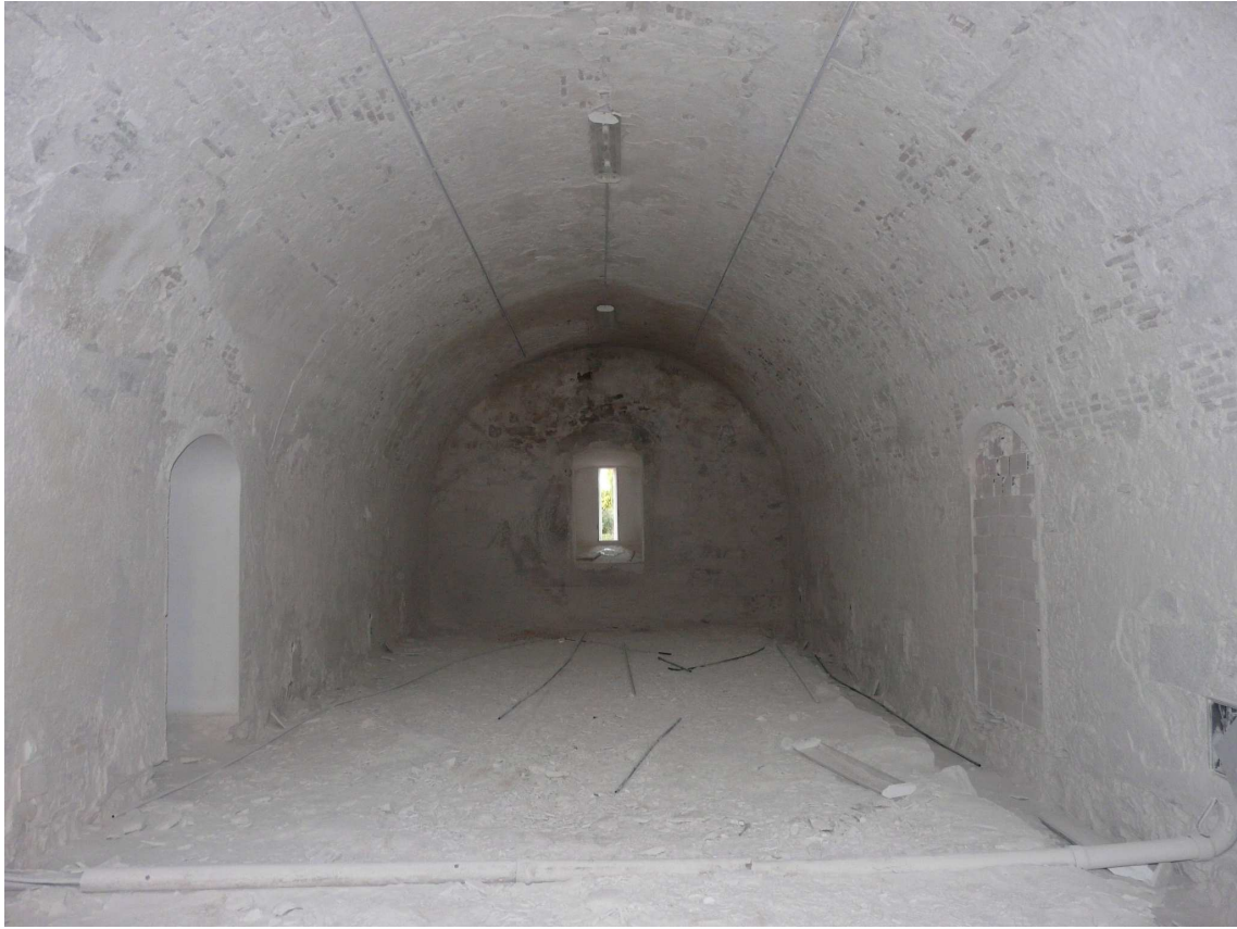
Vista general d'una de les casamates al voltant del pati d'armes corresponents a l'obra nova de la segona meitat del segle XVIII. S'observa la volta de rosca de maó característica.
