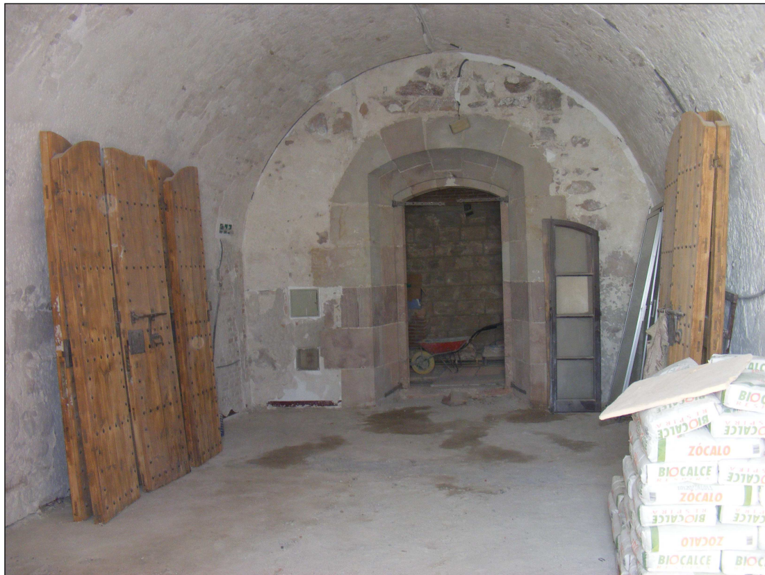
Vista general de la sala 12 una vegada assolit la solera u.e. 223 i acabades les tasques de sorrejat de la volta i paraments de la sala.
