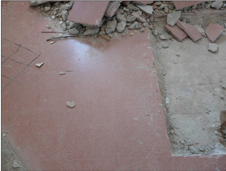
Detall del paviment u.e. 1 i primeres evidències de la solera u.e. 3.
