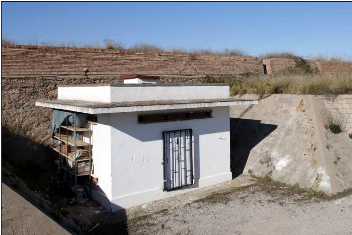
Vista de l'exterior. S'observa el soterrament de l'edifici 9.
