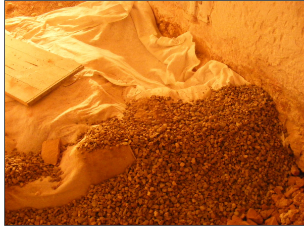
Detall del rebliment amb graves.
