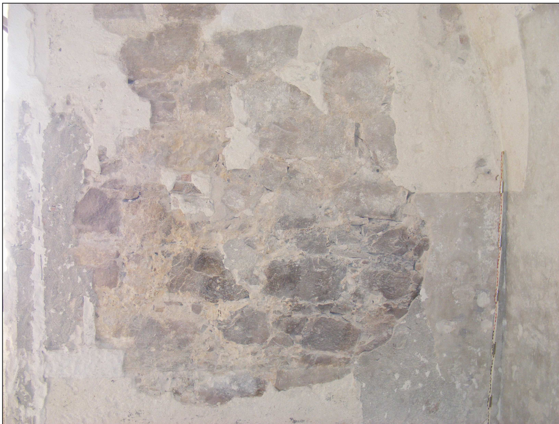
Detall del parament interior del mur u.e. 10.
