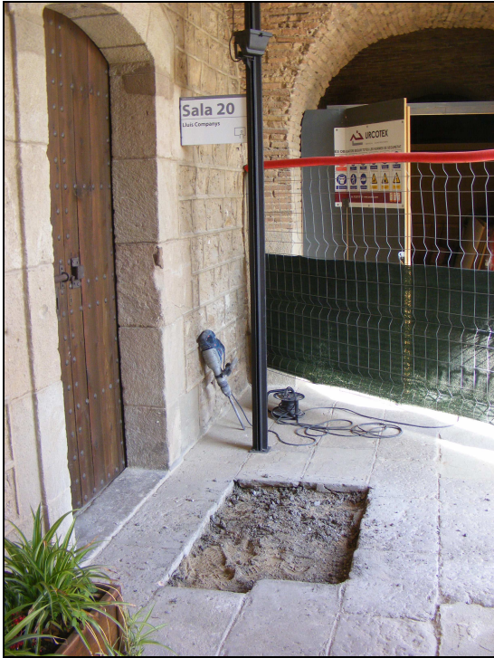
Inici de l'obertura de la rasa de serveis.
