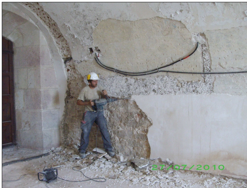
Detall de les tasques de repicat dels paraments.
