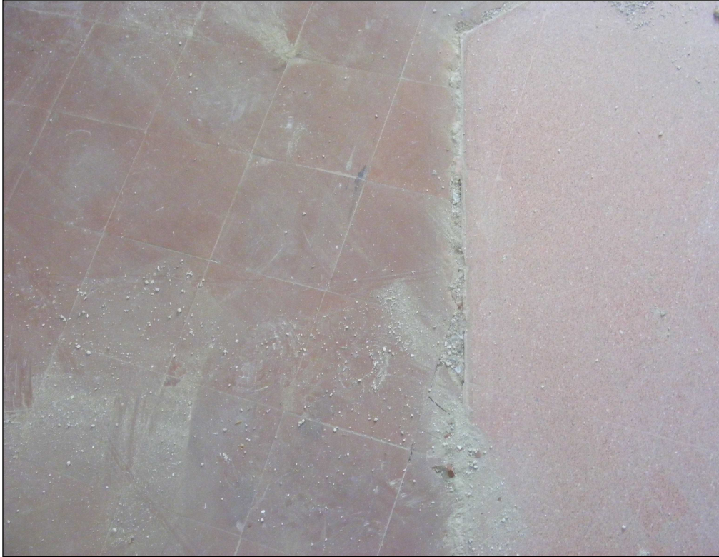
Detall dels dos paviments a l'inici de la intervenció.
