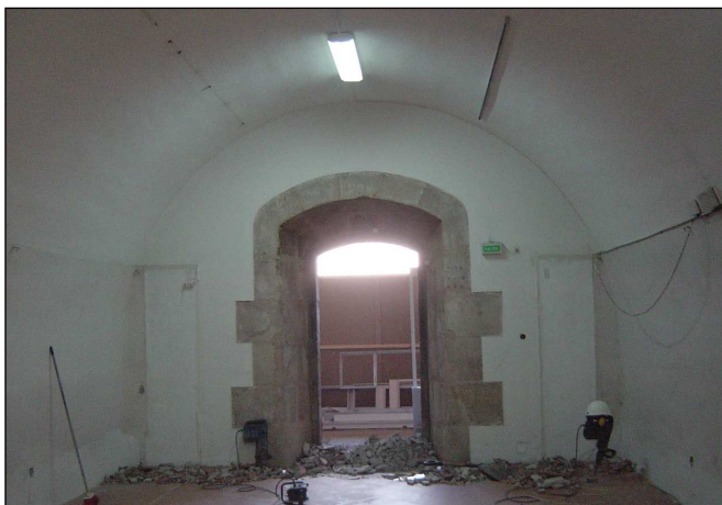
Vista inicial del rebaix del paviment de la sala 16.
