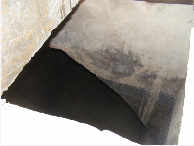
Vista interior de la cisterna.
