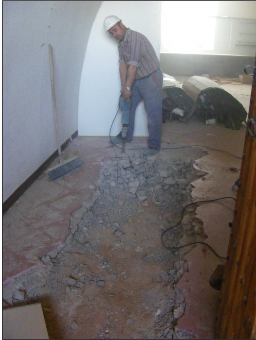
Procés d'excavació de la solera u.e. 174.
