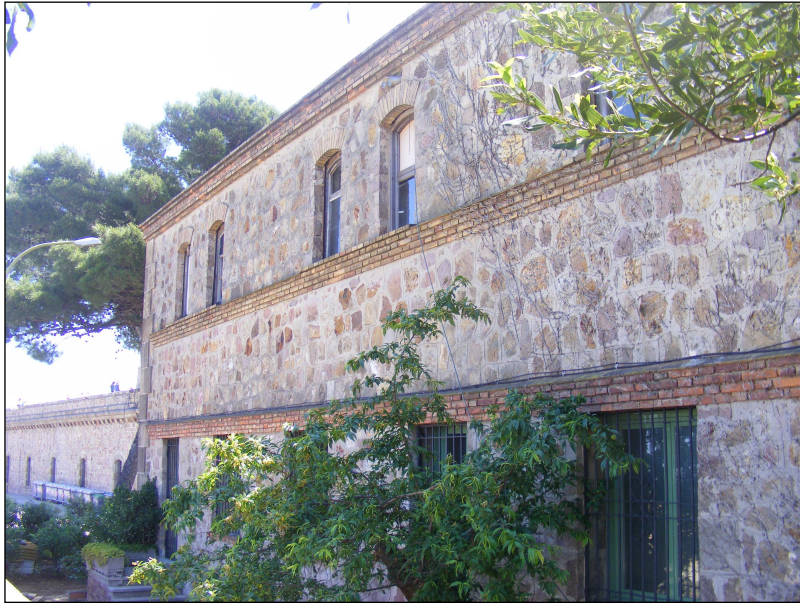
Vista exterior de l'edifici de direcció.
