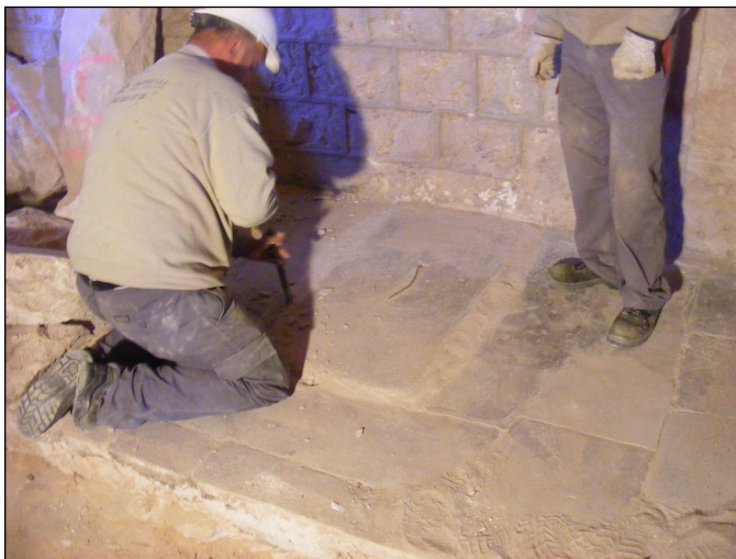
Vista de la trapa d'accés a la cisterna.
