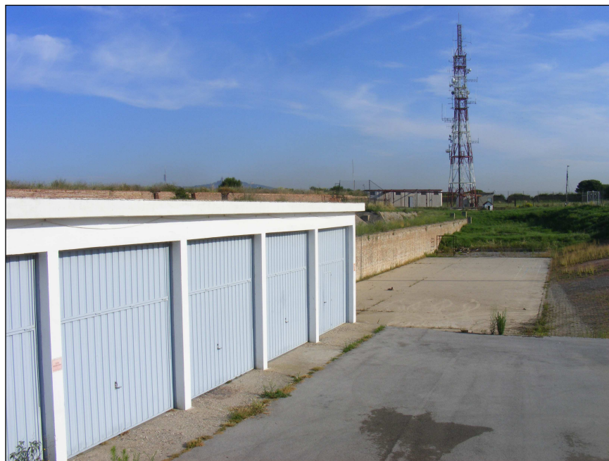
Vista de l'edifici 7 adossat al mur de la Bassa.
