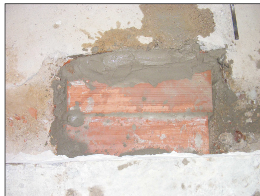
Maons que cobreixen la u.e. 262 i que permet el manteniment de la canal en ús i el pas dels serveis planificats.
