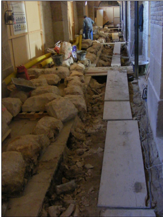
Procés d'extracció del paviment i aflorament de l'estrat u.e. 204.
