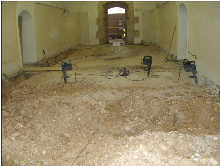
Vista general de la sala 15 en el procés de rebaix dels nivells moderns.
